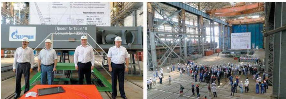
Рис. 5. Торжественная церемония закладки опорного основания ЛСП «А» для освоения месторождения Каменномысское-море
