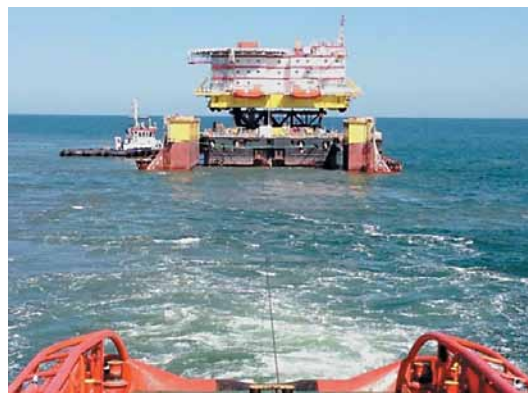
Рис. 17. Заведение транспортно-монтажной баржи и установка верхнего строения в проектное положение
