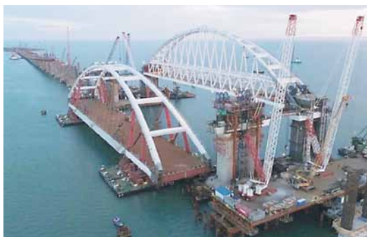
Рис. 15. Плавучая система в процессе заведения, позиционирования и подъема арочного строения
