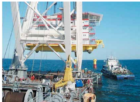
Рис. 5. Подъем верхнего строения и позиционирование
