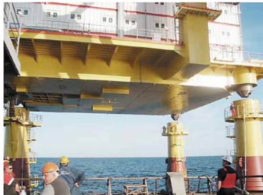
Рис. 6. Стыковка верхнего строения и опорного блока
