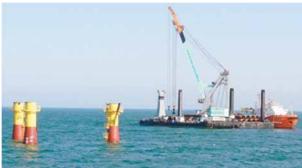
Рис. 4. Завершение постановки и установка свайного фундамента
