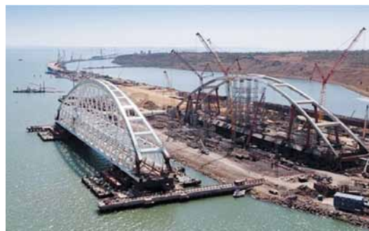
Рис. 13. В ходе выполнения операций по приему веса железнодорожной арки и момент отрыва арки от стапеля
