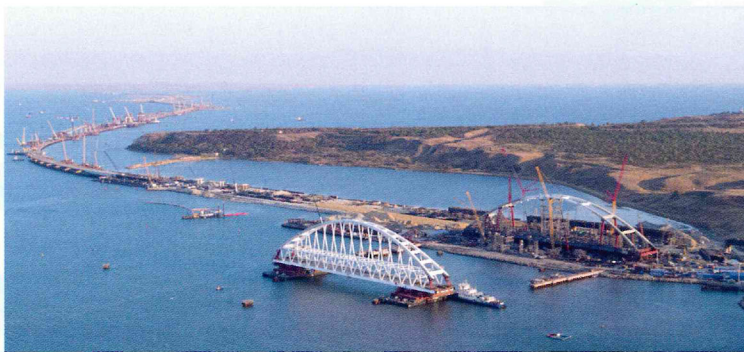
РИС. 14. Плавсистема для морской операции по установке пролетов Керченского моста
