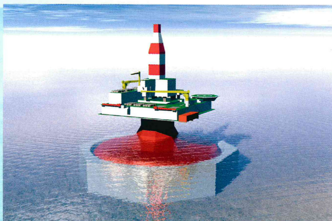
РИС. 7. ЛПБУ для круглогодичного разведочного бурения
